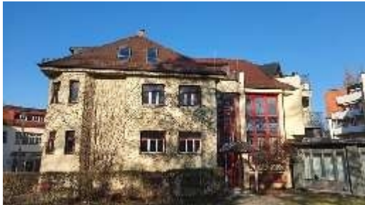
Ostansicht Bauteil E vor Abbruch
